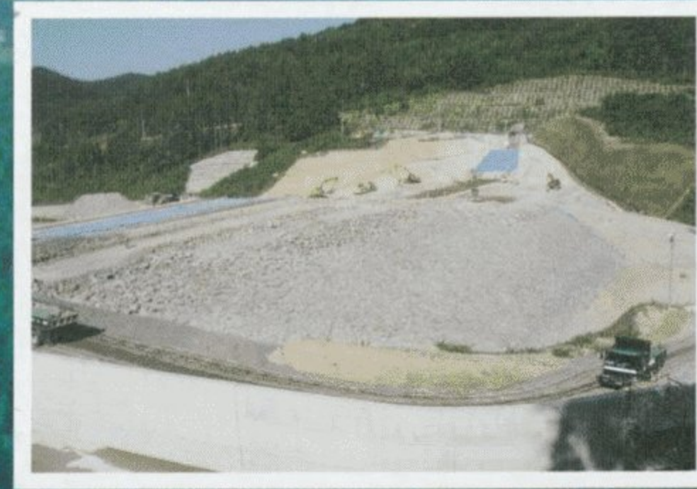
ロックフィルダム堤体盛立
