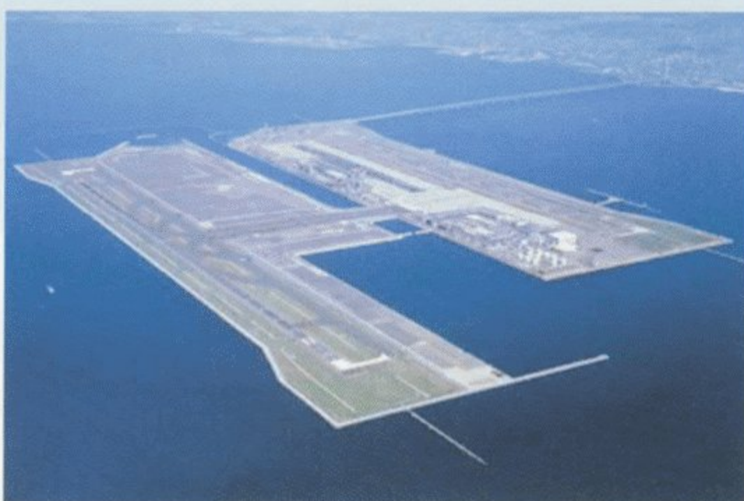
関西国際空港第二期工事
