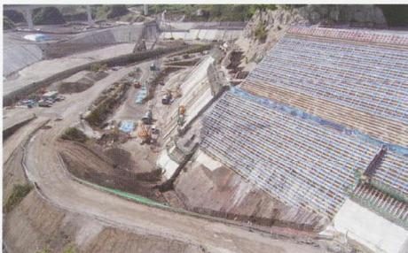
稲葉ダムにおける貯水池表面の遮水工事。本工事において、コンクリートフェーシング工で鞍部CSG施工を実施しました。CSGはプラントで製造された材料を運搬して敷均しています。
