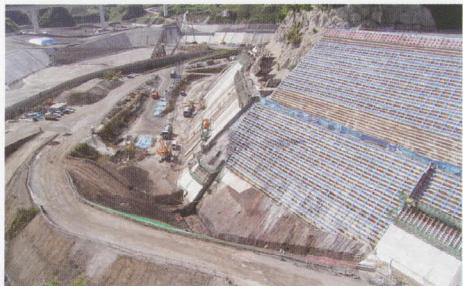
稻葉ダムにおける貯水池表面の遮水工事。本工事において、コンクリートフェーシング工で鞍部CSG施工を実施しました。CSGはプラントで製造された材料を運搬して敷均しています。
