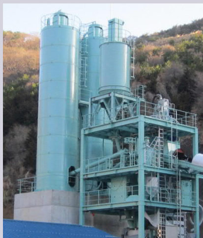
造粒固化施設
